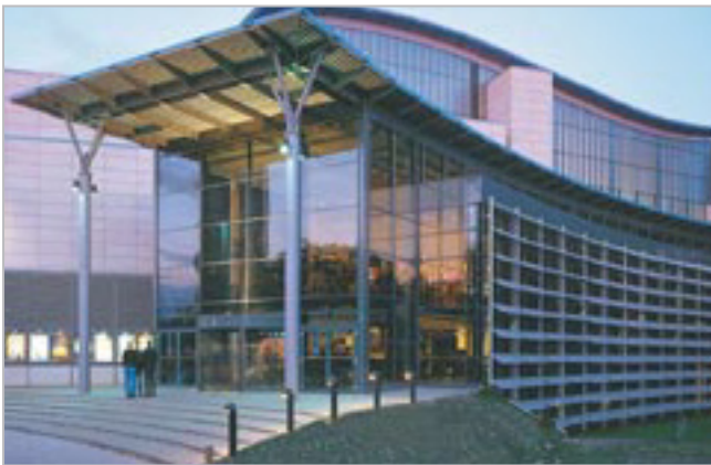
Die 350 Mitarbeiter des Geschäftsbereichs Hochbau in Deutschland, Österreich und der Schweiz erstellen komplexe Glasdächer und Fassaden wie am Cinemaxx Hamburg
